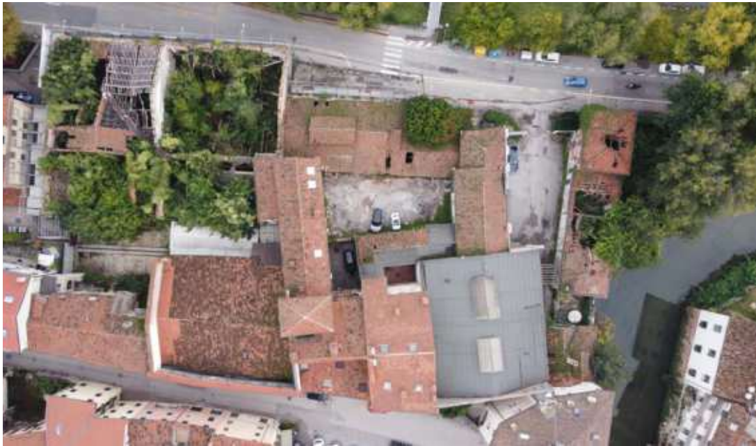
vista aerea effettuata mediante drone
